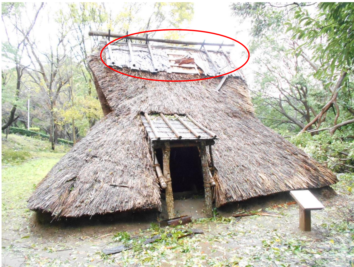
郷土博物館奈良時代復元住居棟部被災状況写真
