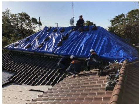
ブルーシート展張作業
