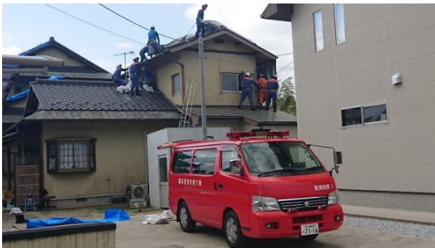
ブルーシート展張作業
