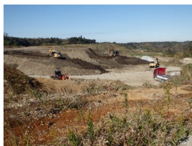
写真 建設発生土の埋立て事業場
