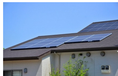
写真 太陽光発電システム
