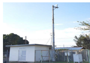
写真 大気環境常時監視測定局
