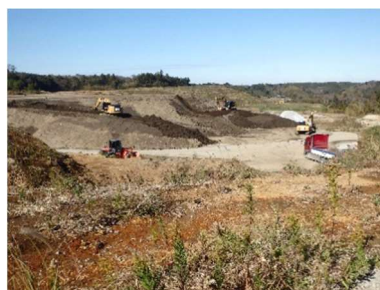
写真 建設発生土の埋立て事業場
