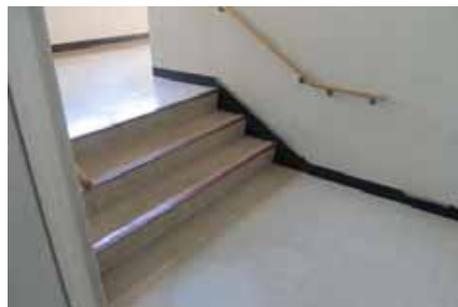
旧庁舎2階と新庁舎2階の接続部分において段差が生じており、段差解消には大規模な改修が必要
