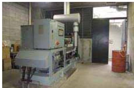
電気室・発電機室が地下にあるため、浸水時には機能しない恐れがある
