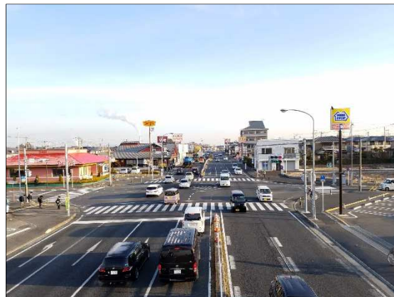
国道 16 号沿いの商業業務地
