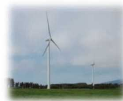
風力発電 (環境省HPより)
