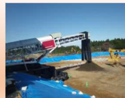
中間貯蔵施設 土壌貯蔵施設
