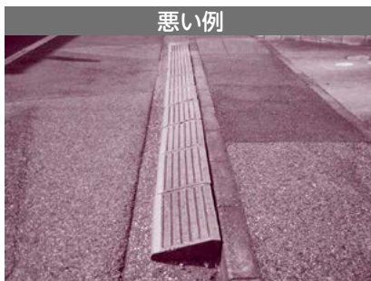
悪い例 ブロックが排水の障害や、歩行者などの転倒事故の原因となります
