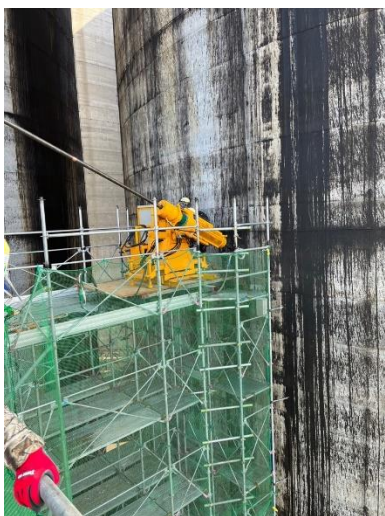
③ランス挿入作業（3月17日）
