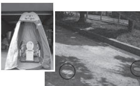
この小さい穴の上に下水道直結式トイレを設置して使います
