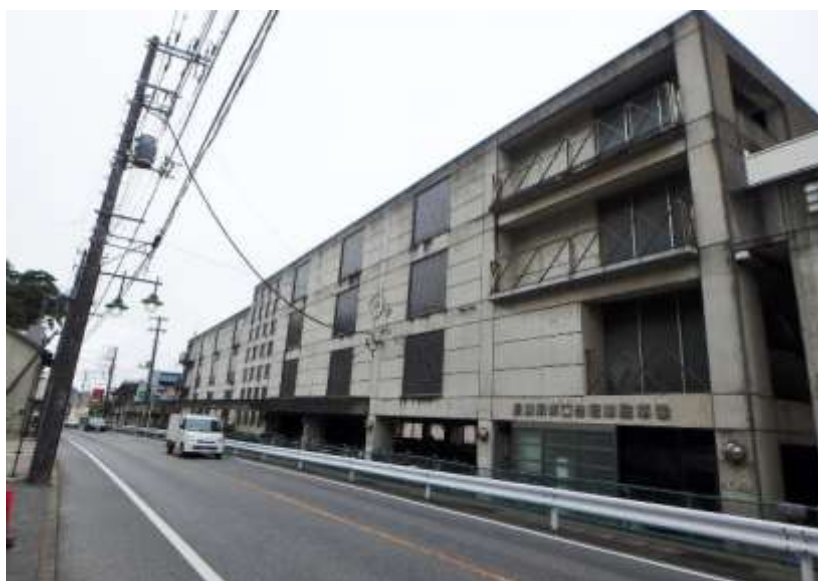
改修工事が予定されている長浦駅南口自転車駐車場
