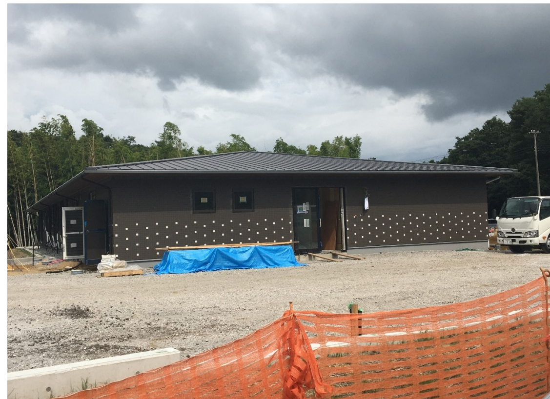
玄関・駐車場側から撮影
