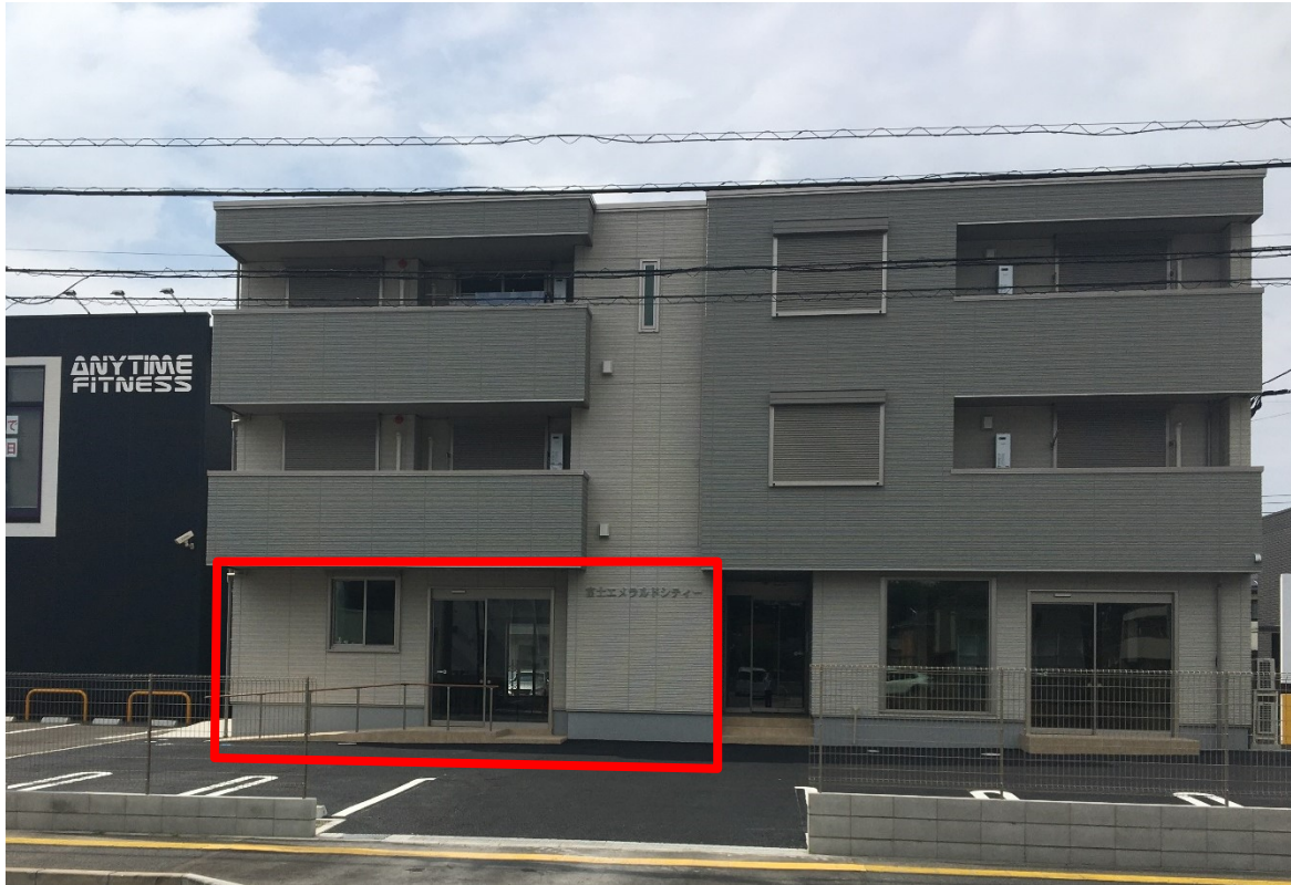
正面から撮影(赤枠内が保育施設部分)
