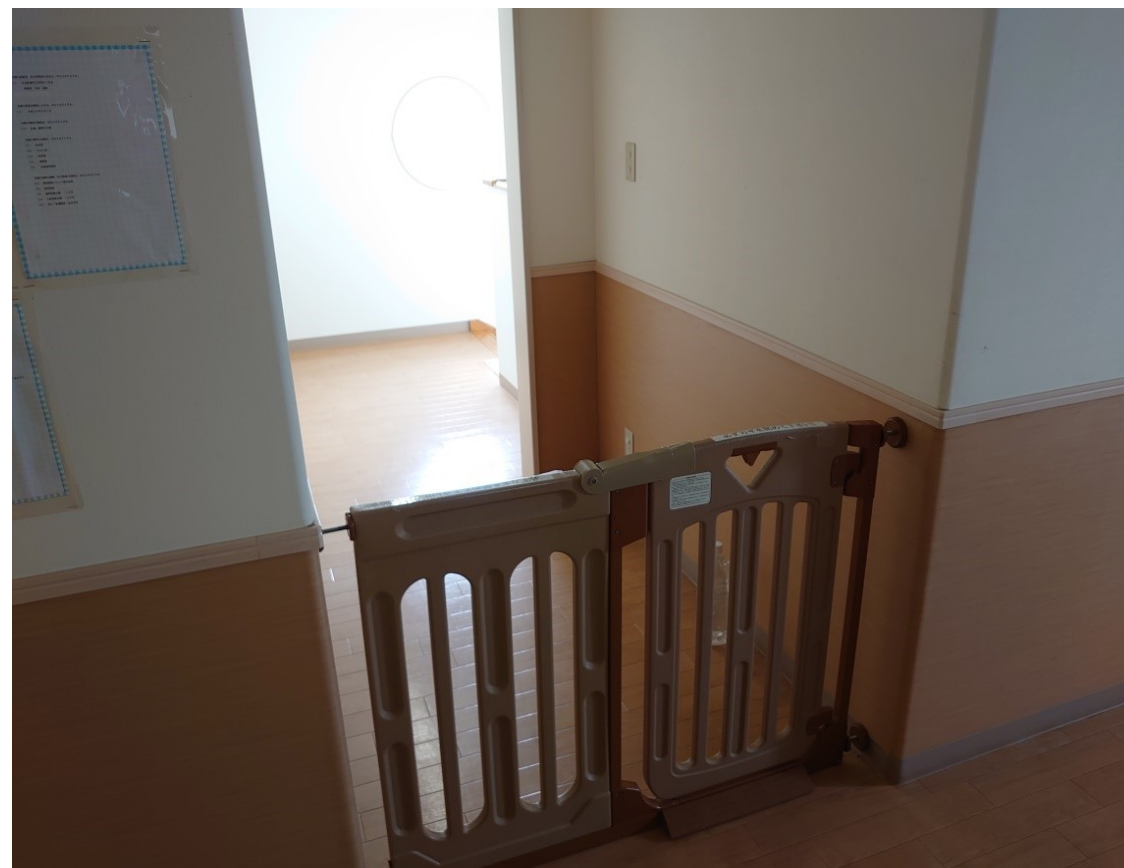
2階階段出入口
