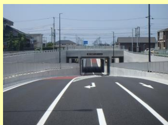
袖ヶ浦駅の南北地域を結ぶアンダーパス
